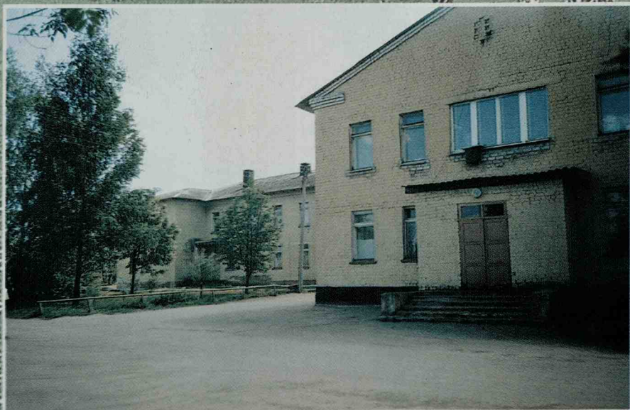
Здание центральной районной больницы п. Верховье.
