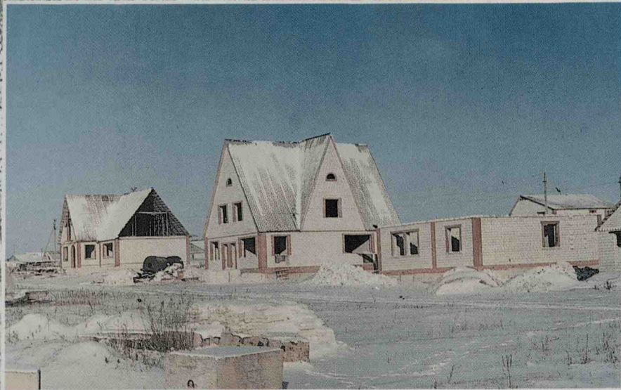
Строительство жилья по программе «Славянские корни» в д. Грязное.
